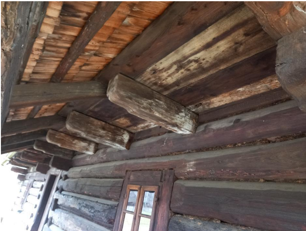
Chałupa z Bażanowic, degradacja biologiczna desek okapowych
