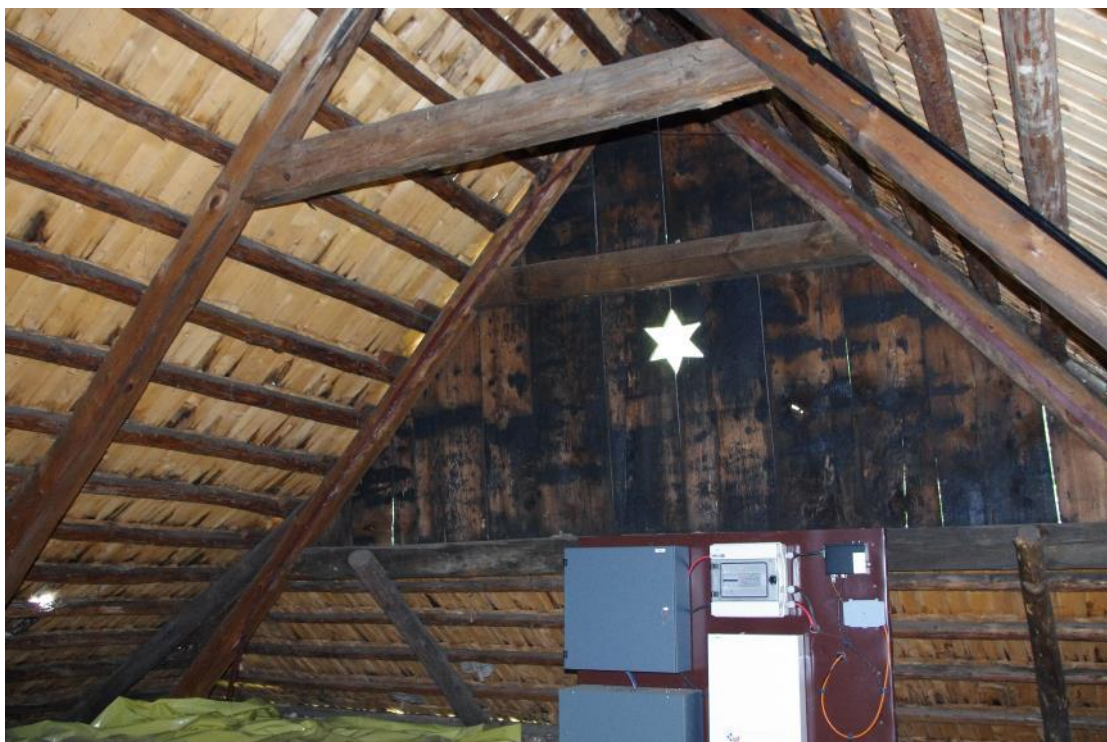
Chałupa z Bażanowic, strych, deski szczytowe
