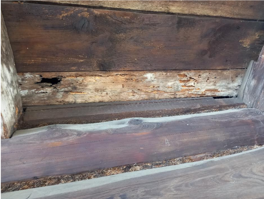
Chałupa z Bażanowic, rozkład biologiczny drewna desek okapu
